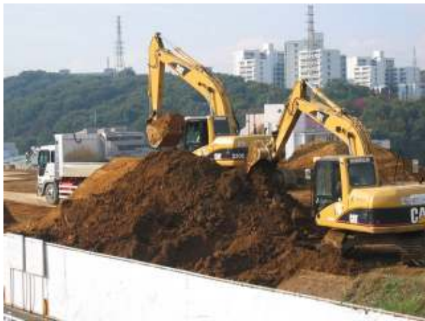
建設工事が始まった現地
